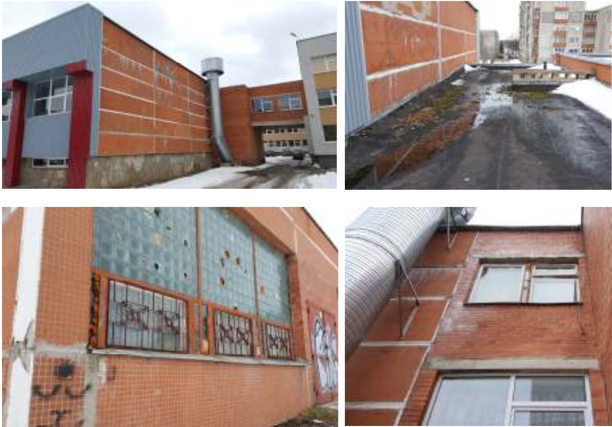
Pav. 3.1 Baseino pastato išorės konstrukcijų būklės fragmentai
