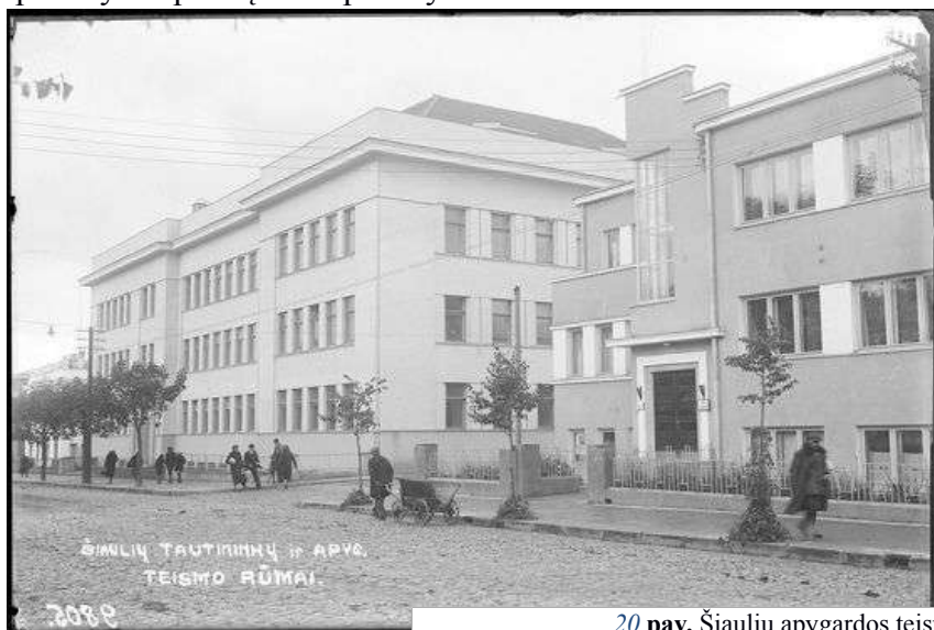
20 pav. Šiaulių apygardos teismo rūmai ~ 1937 m.
