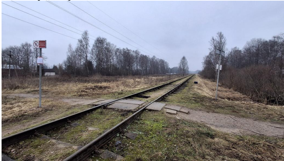
1 Pav. Pėsčiųjų takas per geležinkelio pervažą
