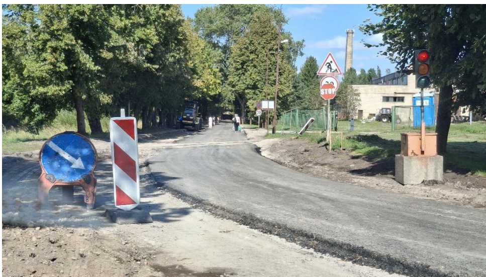
2 Pav. Lingailių g. asfaltavimo darbai
