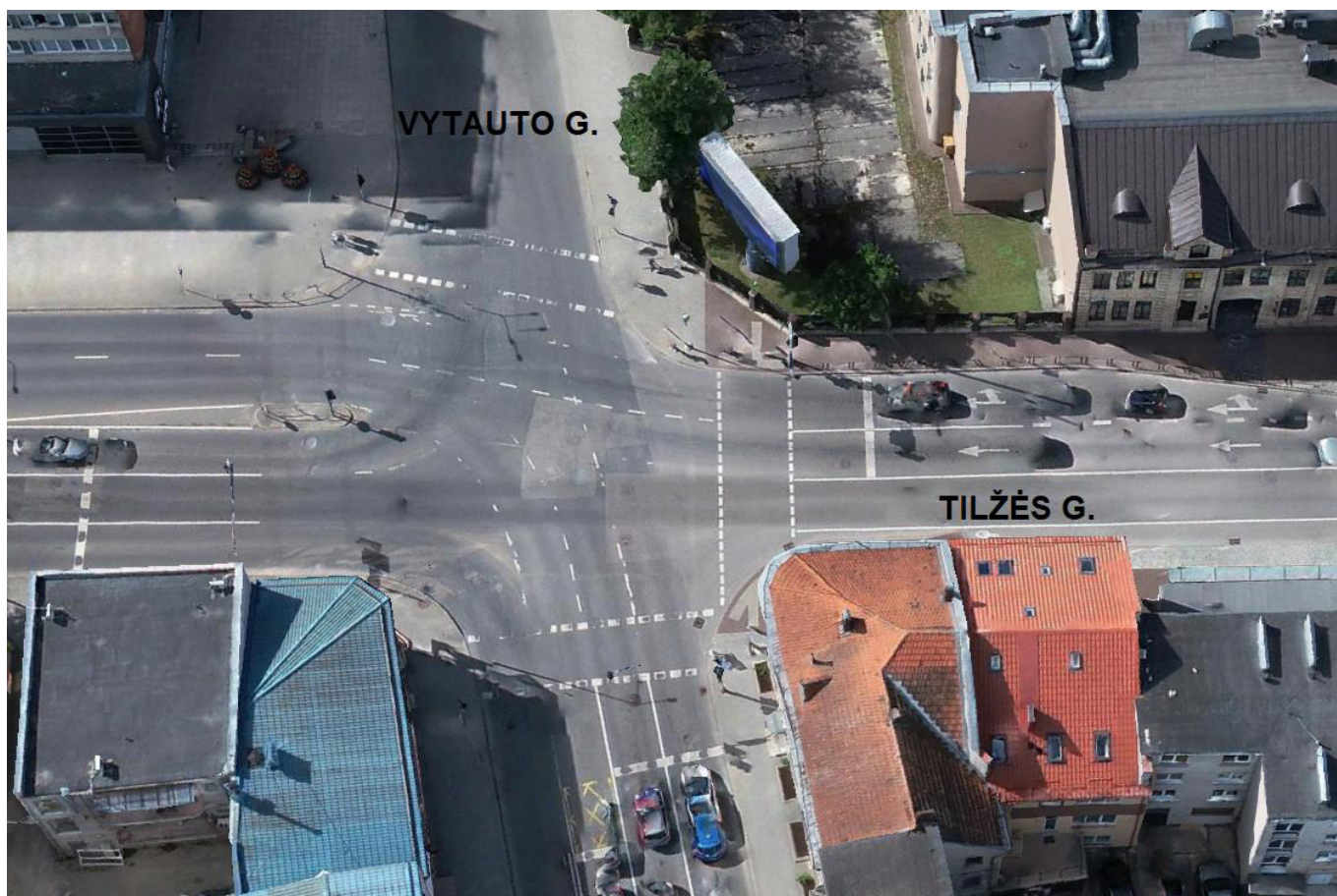
16 pav. Tilžės – Vytauto g. sankryža
