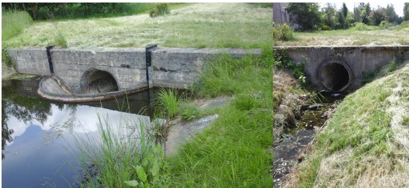
84 pav. Paaukštinta pralaida Kulpės ištekėjime iš Rėkyvos ežero
